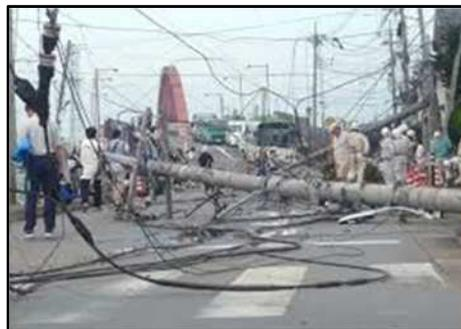
越谷市における竜巻による電柱倒壊
