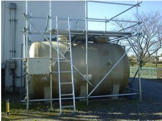
畜舎排水中に少量の空気を2週間送り込みます
