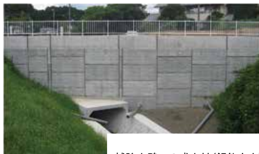
補強土壁工の盛土材（飯能市内）
