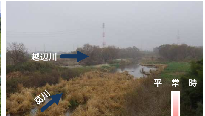
越辺川（葛川水門から下流部）
