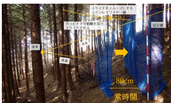
図-7 改良型ゲート設置状況
