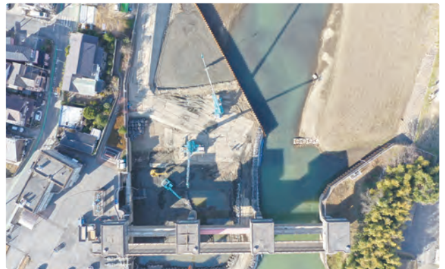
▲工事中 上空写真
