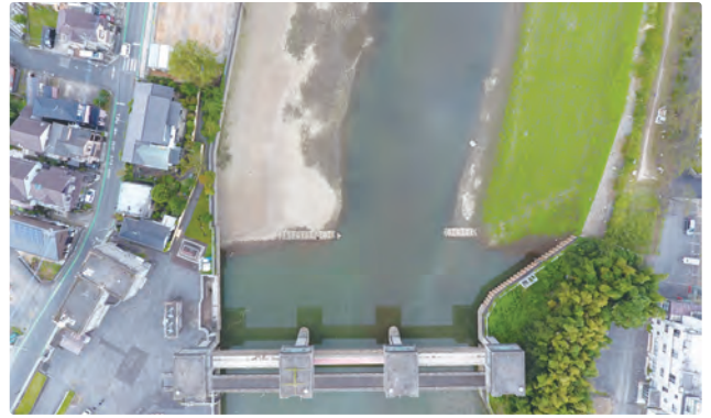
▲工事前 上空写真
