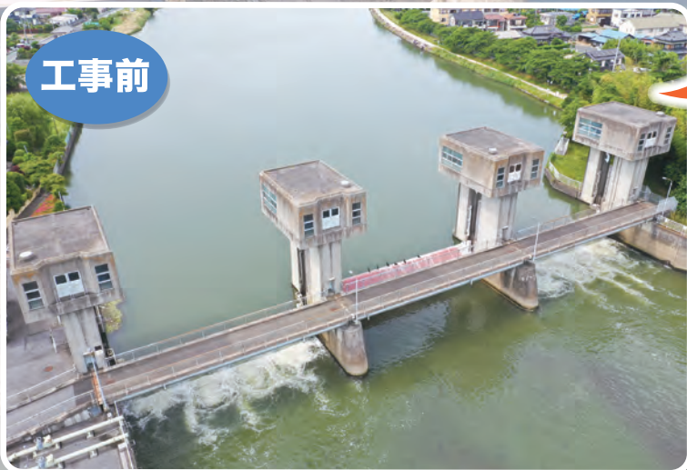
(写真 農地防災事業(施設耐震)古利根堰地区)
