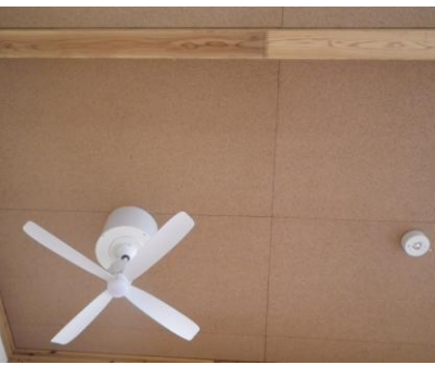
⑤ もみがらボードを使った食堂の天井
