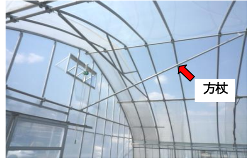
写真5 方杖（ほうづえ）による補強
