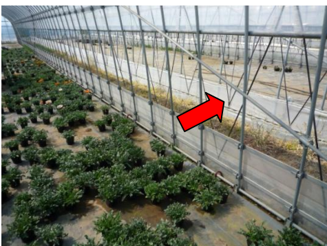
写真3 筋交いによる補強
