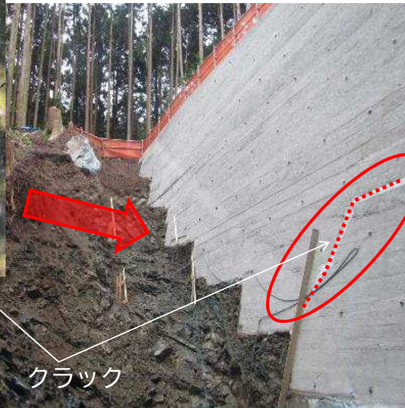
堰堤のクラック補修（後）
