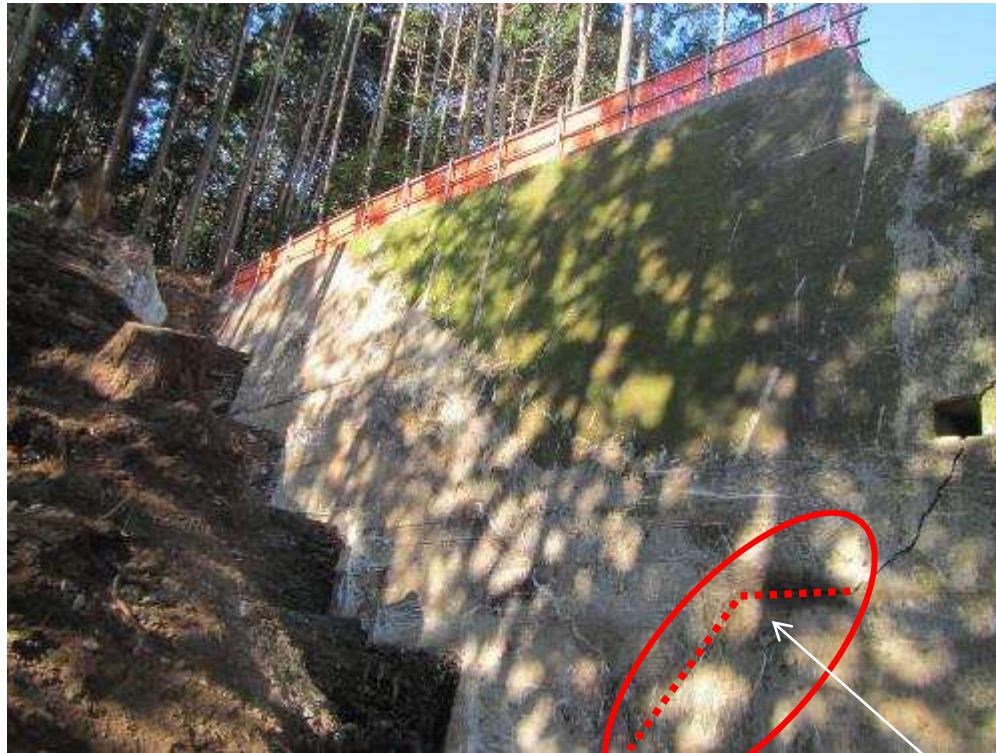
堰堤のクラック補修（前）
