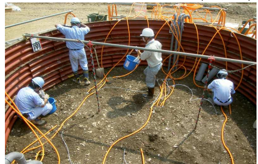
写真2 センサー設置作業
