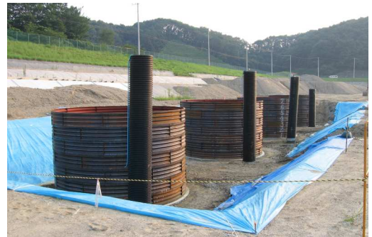
写真1 ライナープレート建設(第1期)
