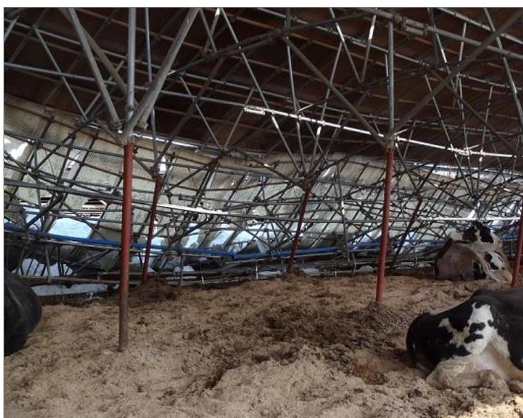
写真1 牛のすぐ近くに落下した牛舎の天井
