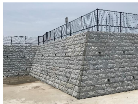
[調整池での使用事例]
