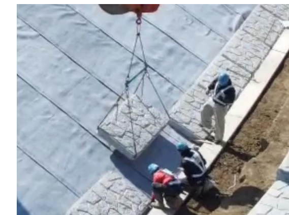
[専用吊具での施工状況]
