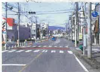
④ 国道299号(道路改築)
