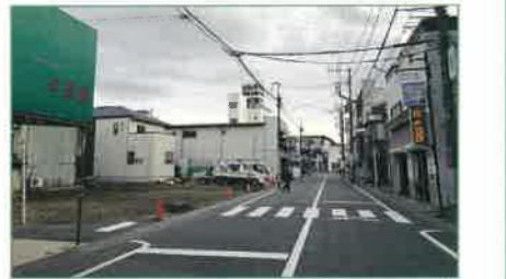
解体作業も進む東武動物公園駅前通り。
