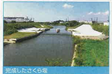
完成したさくら堰
