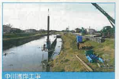
中川護岸工事
