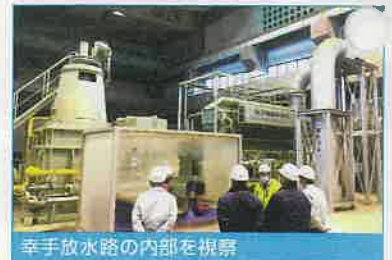
幸手放水路の内部を視察
