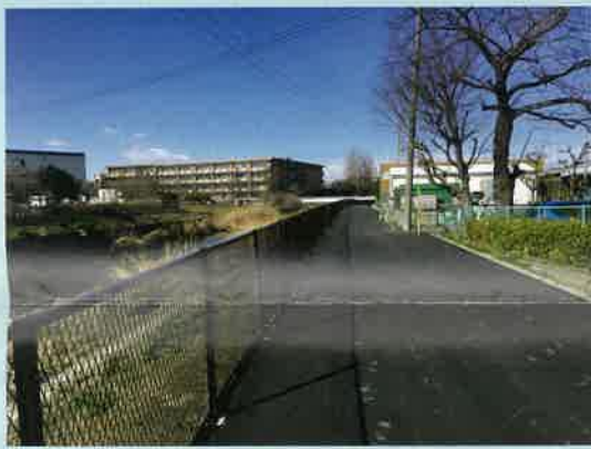
さいたま市立宮前小学校への安全な通学路が欲しいという要望の結果、鴨川土手遊歩道かさ上げ工事・舗装工事が完了しました。
