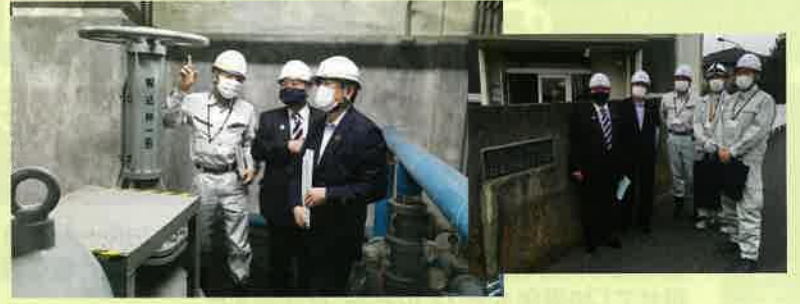
埼玉県荒川左岸南部下水道事務所管轄の日進中継ポンプ場を視察し、老朽化しつつある設備の状況を視察しました。
