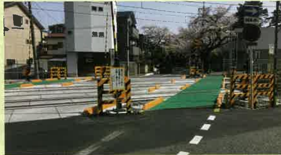
地元より要望がありました北区の盆栽踏切の改修工事が完了し、状況を視察しました。
