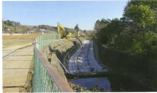
▲鳩川の工事の様子
