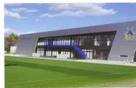
▲クラブハウスとカフェが入る管理棟
