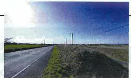
▲125号暫定2車線区間(工事発生土仮置き状況)
