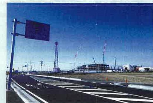
令和3年2月27日、県道加須菖蒲線(菖蒲新道)から地方道加須鴻巣線(騎西新道)までの県道久喜騎西バイパスの一部が開通しました。同バイパスは(仮称)埼玉県済生会加須病院の開院に向けて着々と進められていますが、開通した東側・西側道路の早期完成に向けしっかり活動してまいります。
