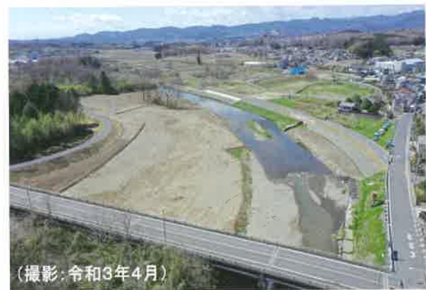
▲樹木伐採、築堤工事が完了した越辺川（今川橋付近）
