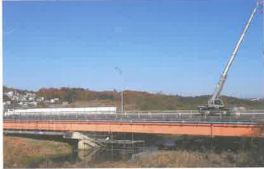
▲越生大橋の工事の様子
