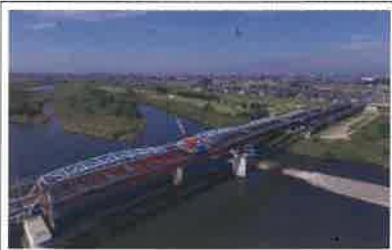
老朽化した橋梁の架換え（上武大橋）
