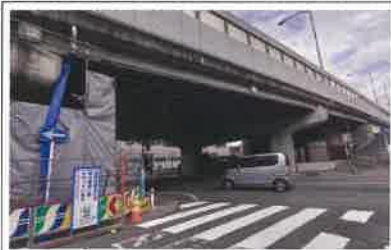
地震対策で橋の耐震補強（新浦和橋）
