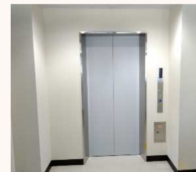
(エレベーター整備)
