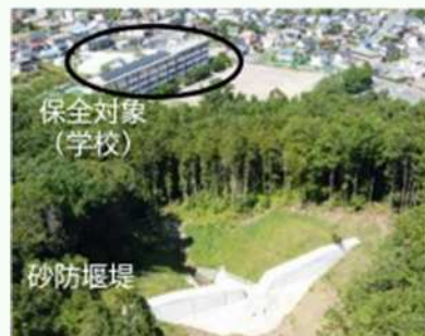
砂防関係施設整備
