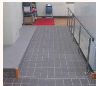
(スロープ整備)
