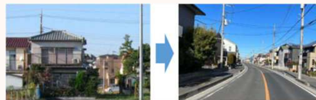
土地区画整理事業により整備された都市計画道路
