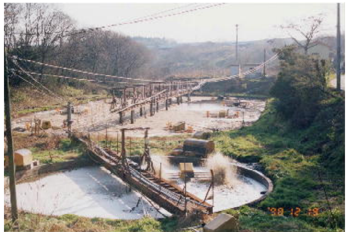
図19 表面曝気式ラグーンの実プラントの様子 （上：反応槽 下：原水槽）
