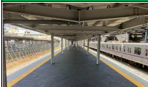
仮下りホーム舗装施工状況
