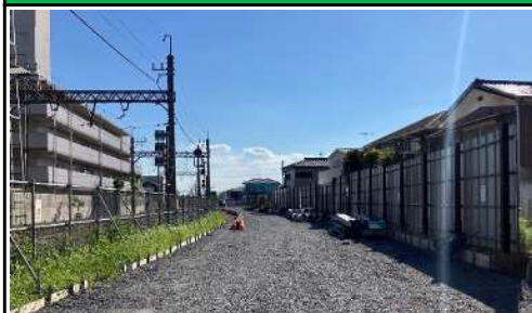
第87号踏切～第88号踏切間 路盤施工状況
