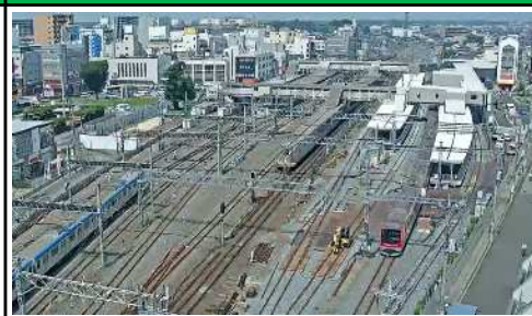
春日部駅構内工事施工状況
