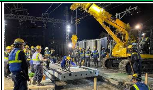
第124号踏切道 連接軌道ブロック設置状況
