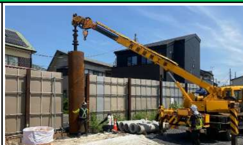
電路柱基礎施工状況
