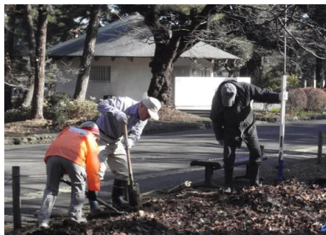
↑ 土壌改良作業の様子①
