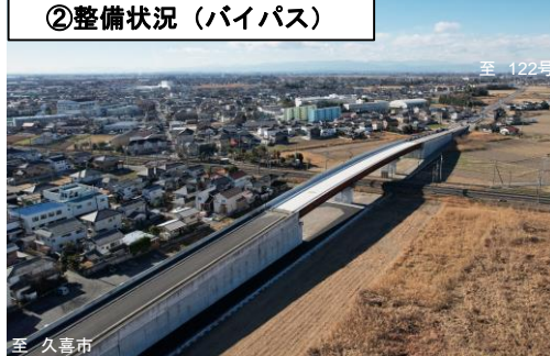
②整備状況(バイパス)
