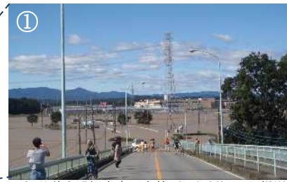
一般県道岩殿観音南戸守線（早俣橋）から撮影
