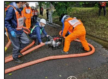
(排水ポンプ設置)
