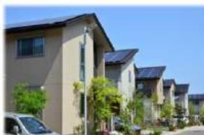
再生可能エネルギーによる暮らし
