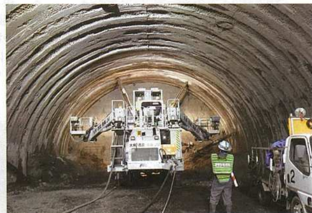
油圧ドリルジャンボ施工状況
