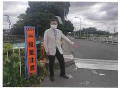
緊急工事 芝川の橋「八丁橋」
