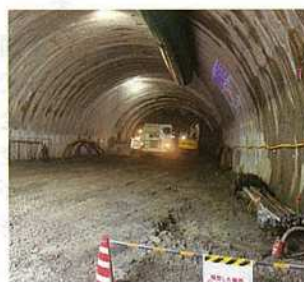
発破によって生じた土砂をすくって運搬する「ずり出し」の様子。
