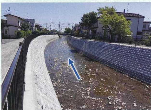
山王橋上流部完了状況
