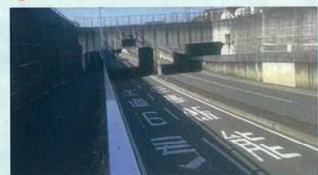
⑧ 東京堀兼狭山線(狭山トンネル)
