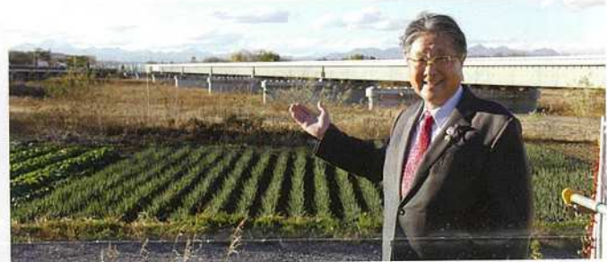
▲新神流川橋は今年中の完成を目指し現在急ピッチで工事が進められています。
