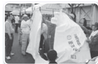
一致団結で仮設トイレ設置
