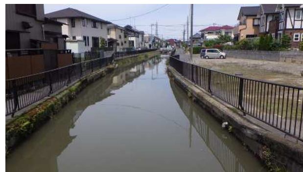
整備前（徒歩橋上流）加須市大門町地内
