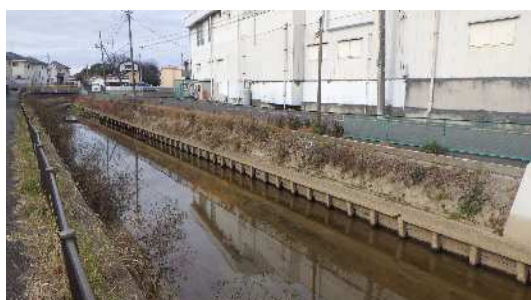
令和5年度整備予定箇所 （栄橋上流）加須市浜町地内
