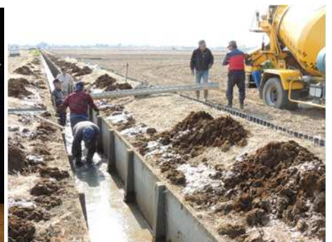
▲直営工事（水路の底打ち）
