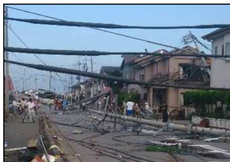
突風による電柱倒壊 (越谷市)
