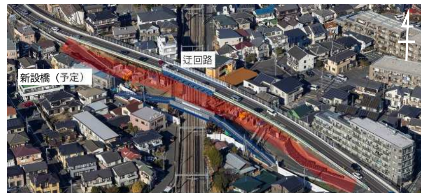
橋りょう架換え工事 国道463号（建武橋）
