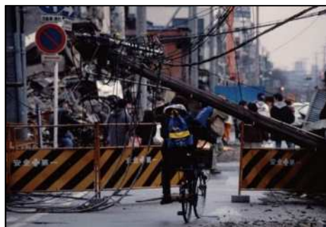
阪神淡路大震災による電柱倒壊
