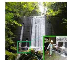
砂防堰堤 槻川 (東秩父村)
