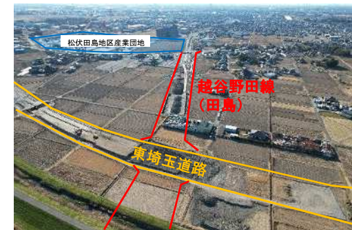
整備状況 ⑧越谷野田線(松伏町・田島)
