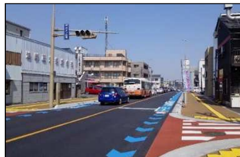
無電柱化の整備箇所 (都) 中央通停車場線 (志木市)
