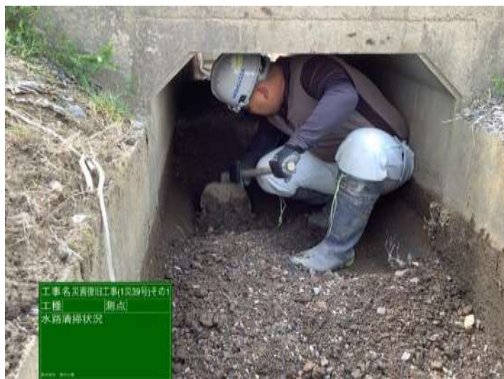
水路内体積土砂撤去
