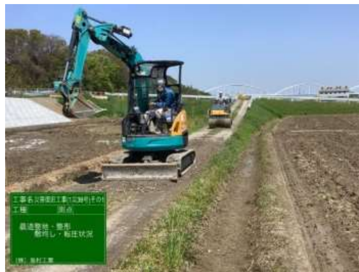
周辺道路の整備
