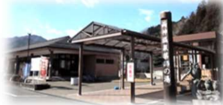
木質バイオマスボイラーによる道の駅への熱供給
