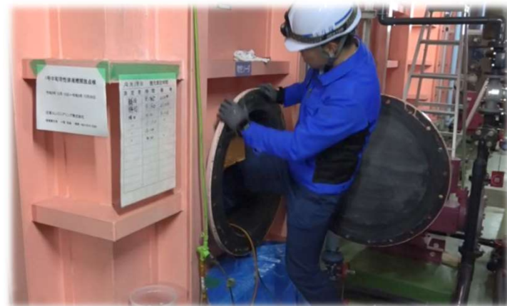
委託業者による点検に立会う様子
