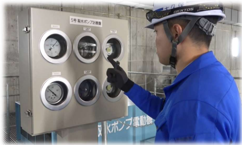
設備点検の様子
