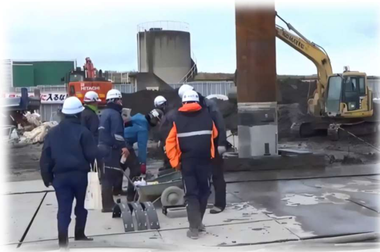
基礎杭打工 現場立会い
