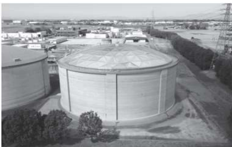
浄水場の貯水タンク（PC浄水池）
