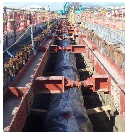
写真 送水管の布設状況
