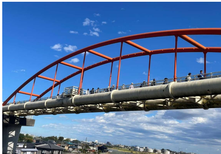
写真 荒川水管橋見学会の様子(鴻巣市)
