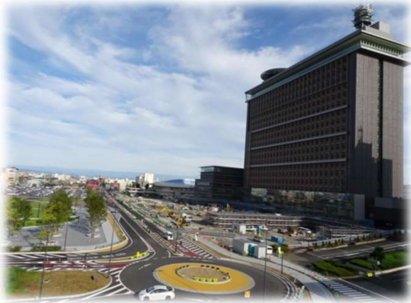
岐阜県庁舎（令和4年度竣工）
