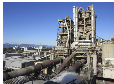
セメント原料化による廃棄物の再資源化を行うセメント工場 (太平洋セメント(株)提供)
