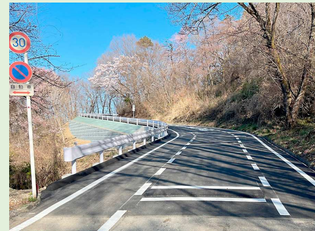
災害から復旧した美の山公園道路
