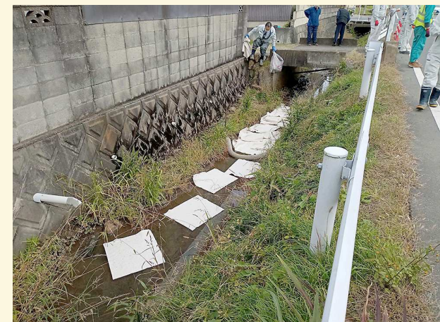
油の流出による水質異常対応の状況
