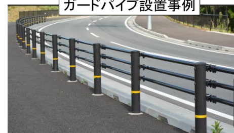
ガードパイプ設置事例
