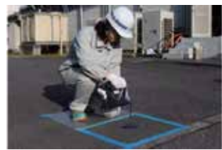
混合したものを均して敷きます
