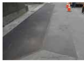
施工例 路面凹凸の平滑化
