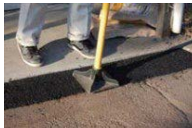
上から転圧します
