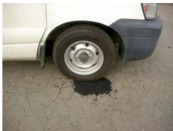
② 車で転圧して施工完了!!
