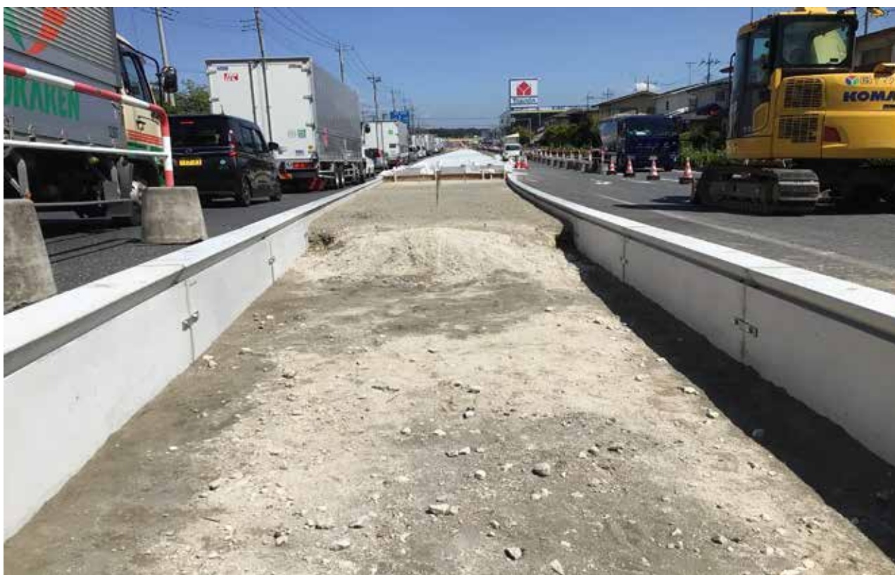
中央分離帯施工状況
