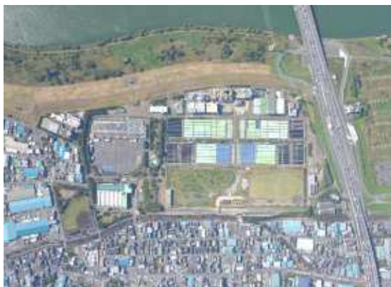
荒川水循環センター(戸田市)
