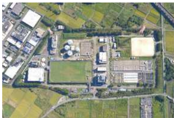
元荒川水循環センター(桶川市)
