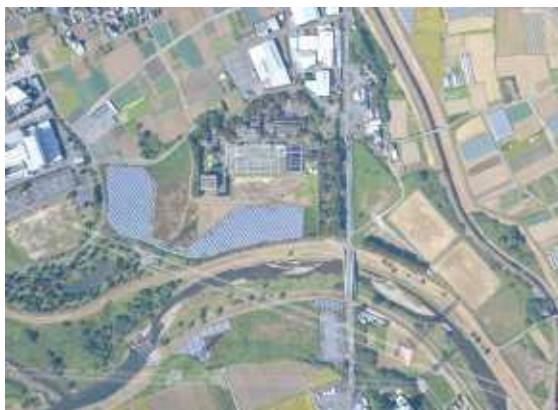
小山川水循環センター（本庄市）
