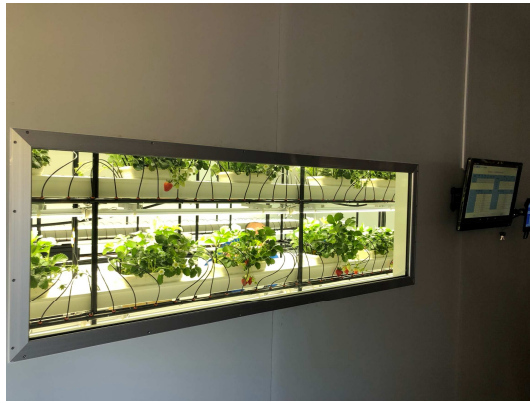
【温湿度・養液・CO2・栽培光管理するIOTスマートコントローラ】 栽培室外から栽培状況を設定、管理します
