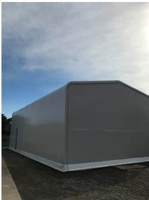
【閉鎖型イチゴ工場外観】 2重の断熱構造となっています
