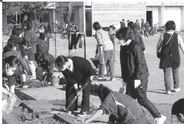
PTA及び学校応援団が 生徒と共に側溝掃除を行っている様子
