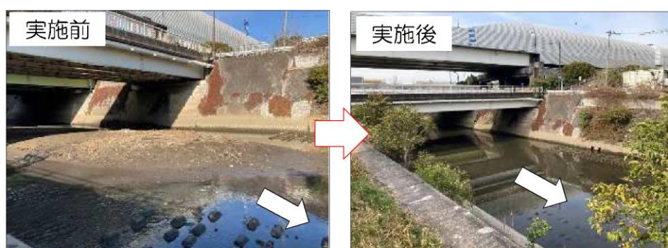
図 1-16 河道の土砂撤去（浚渫）
