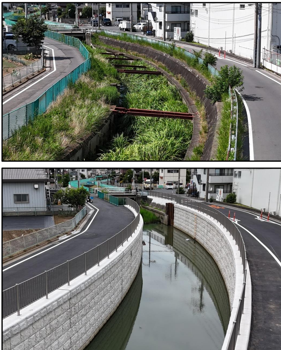
図 1-20 さくら川の改修済みの整備状況 (上図：整備前、下図：整備後)
