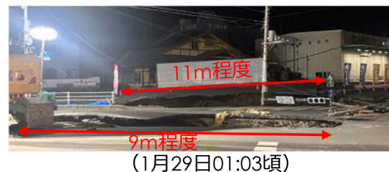
図1.2 道路陥没の拡大
