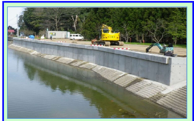
④施工完了
