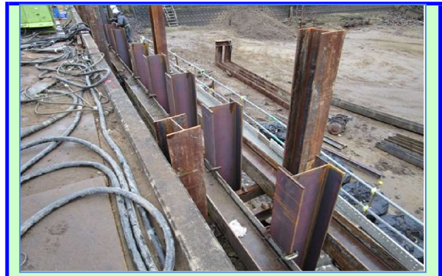
②H杭施工状況
