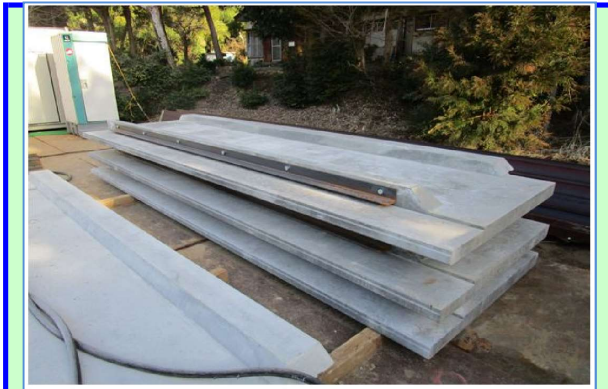
①縦矢板 部材 現場仮置き
