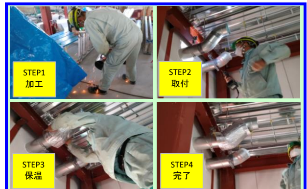
2022年10月_現地施工状況(従来工法)
