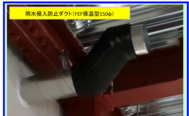
2022年10月_新製品現地施工写真その2
