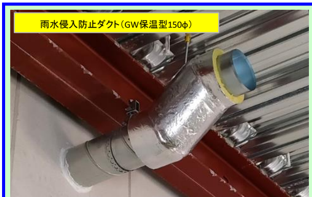
2022年10月_新製品現地施工写真その1
