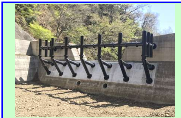
東沢砂防堰堤 設置後
