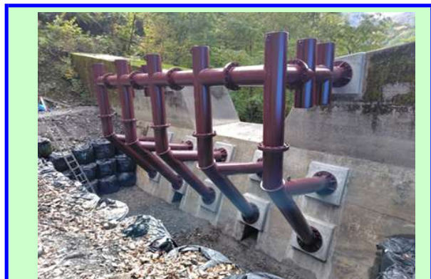
岩屋沢砂防堰堤 設置後
