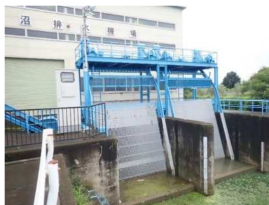
堤体の下流に住宅や道路が近接するため池（大沼（大）・吉見町） 経年劣化のため除塵機を補修（男沼排水機場 熊谷市）
