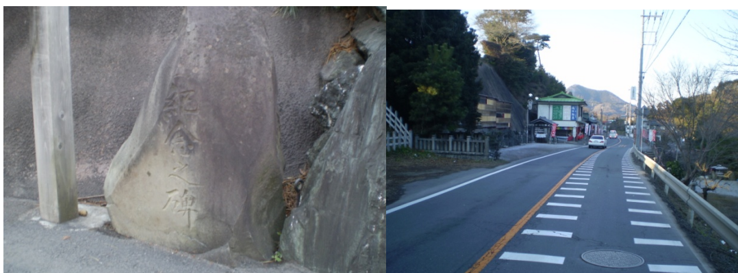
上半分が割れてなくなっている
