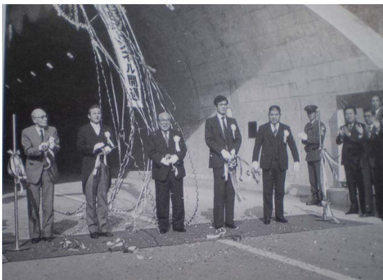
正丸トンネル開通（昭和 57 年 11 月）
