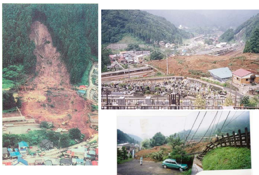
吾野駅の被災状況
