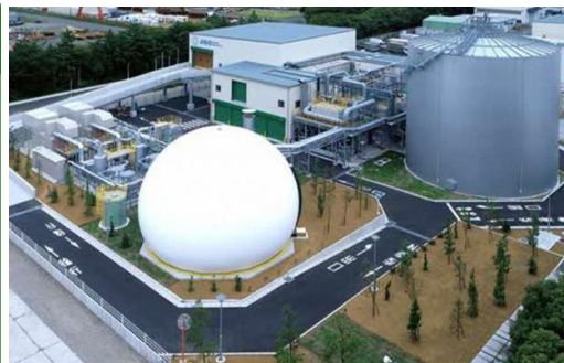
(株)Jバイオフードリサイクル (バイオガスプラント)
